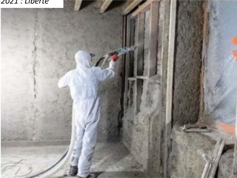
À Verson, sur le chantier des ateliers de rotation, on utilise le béton de chanvre pour isoler des parties du bâtiment.
