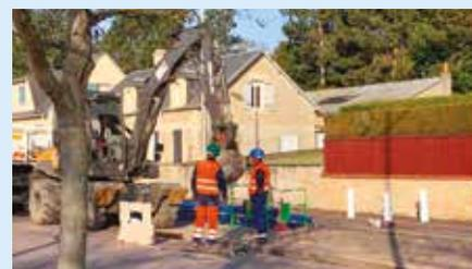
Suite à un problème d'eau colorée et à une expertise de la conduite d'eau par le service exploitation, pôle eau potable de Caen la mer, le renouvellement de la canalisation d'eau potable du numéro 144 bis au 168 rue du Général Leclerc est en cours.
